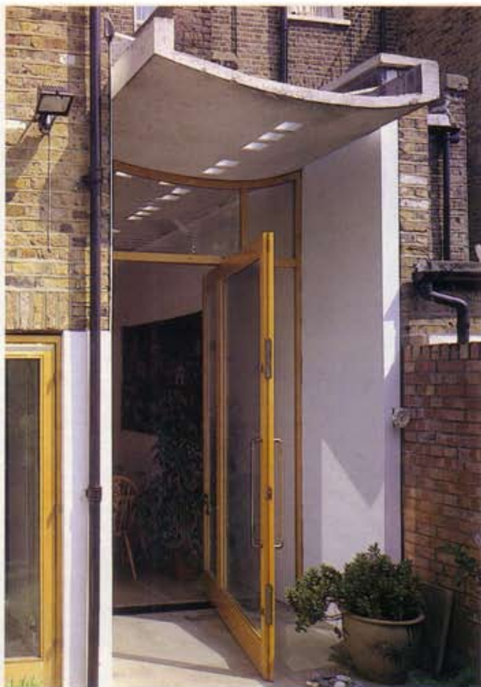
Der Einbau mit dem Betondach schiebt sich nach draußen
